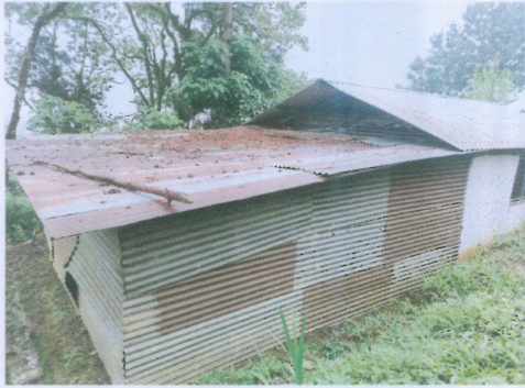
Foto 6: Sustitución de techo de lámina a lámina Troquelada calibre 26
