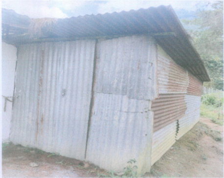
Foto 1: Mejoramiento de aula tipo portico
