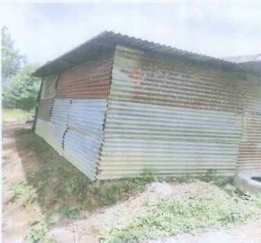
Foto 2: Sustitucion de pared de lamina a block
